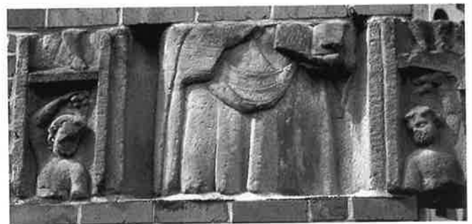
Reliefblock eines römischen Pfeilergrabmals, eingebaut in die Außenwand der Zülpicher Pfarrkirche St. Peter (Kat. II, 6)
