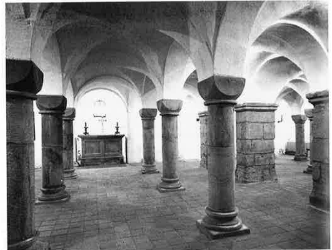
Krypta der Peterskirche in Zülpich (alte Aufnahme)
